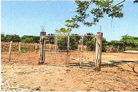
Foto 1: Sustrucción de portor en mal estado
