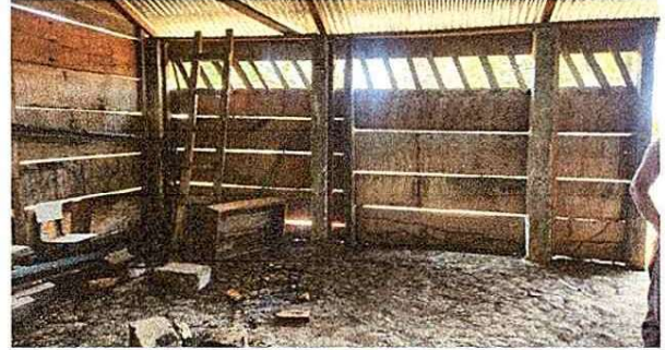
Foto 2: Mejoramiento de interior y piso de cocina
