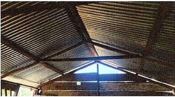
Foto 3: Sustrucción de Esctructura de madera por metal y cubierta de lamina
